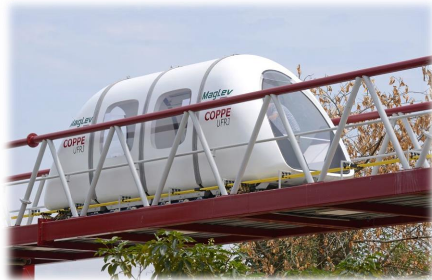
Figura 3.2. Via elevada e veículo do protótipo operacional do Maglev Cobra na Cidade Universitária da UFRJ
